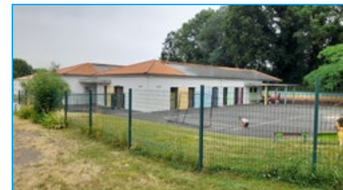
École Sœur Emmanuelle construite en 2009
